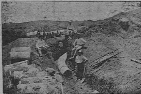
Trabajando en la colocación de tubos de la nueva cañería de las fuentes de LORO
