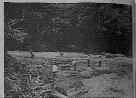
Nacimiento y tanques de captación de las fuentes de LORO unidas a las fuentes de ARIAS, abastecen de agua a la ciudad de Cartago
